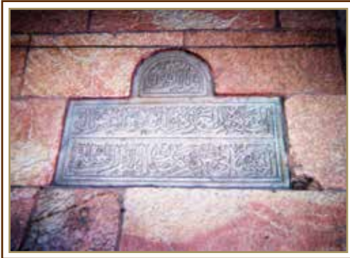
لوحة على مدخل العمارة محفور عليها ”إن هذه العمارة ملك لتوفيق أبوغزاليه أنشئها في غرة رمضان المبارك سنة ١٣٥٣ هـ“
